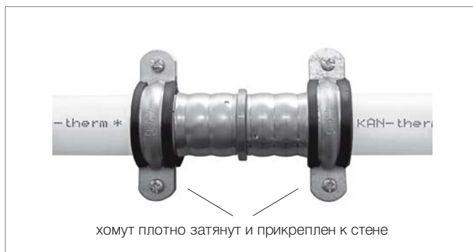
Выполнение точки неподвижной опоры рядом с двухсторонним соединителем..
